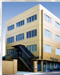
本社ビル 大阪市旭区高殿 1-6-17
