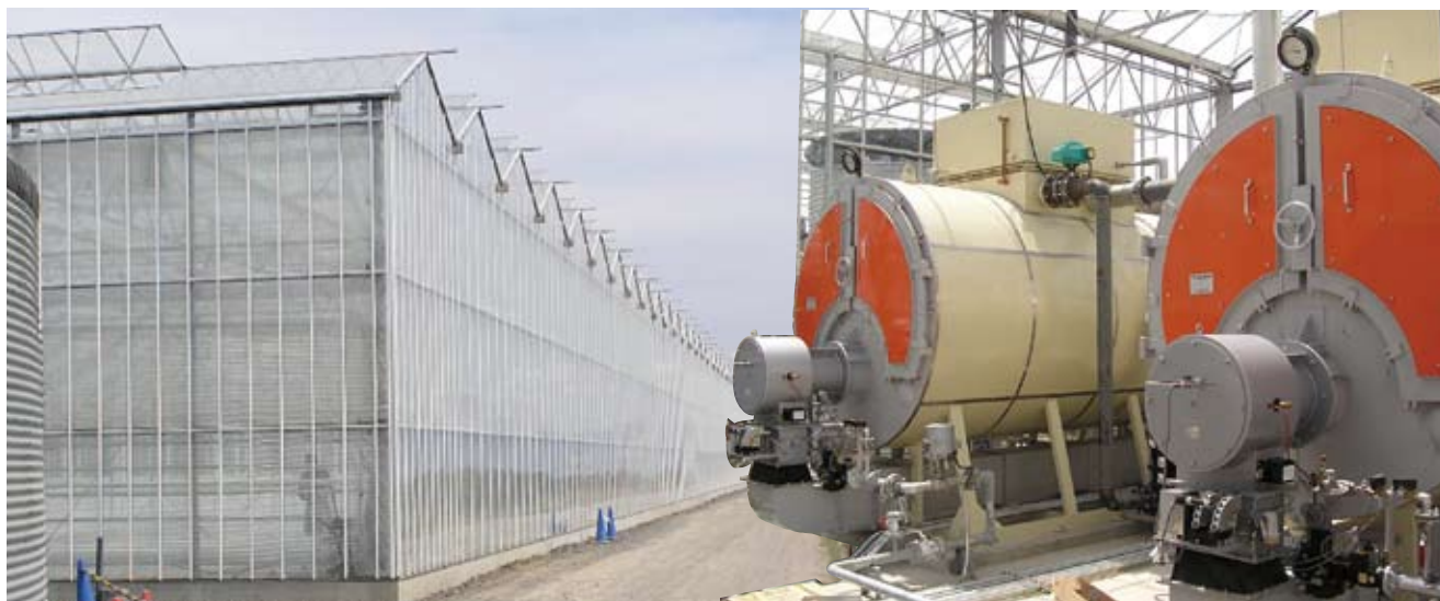
(株) タケザワ様 BW-BG 3 型ボイラ ボイラ出力 2326kW バーナ型式 CG-3P
